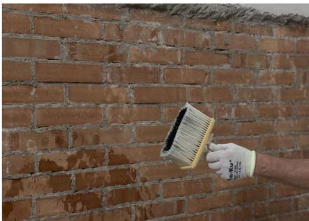
Aplicar **FASSA ONE DRY** después de humedecer la superficie de colocación, evitando la formación de estancamientos superficiales o velos de agua. Las superficies poco absorbentes, como algunos tipos de mampostería de piedra y las superficies de hormigón, deben tratarse primero con el salpicado S 650.
