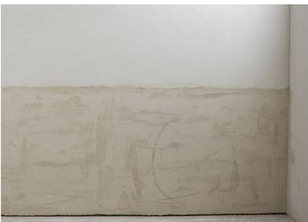
Una vez que **FASSA ONE DRY** ha curado completamente, la intervención procede con la aplicación de un revoco de acabado transpirante, como el S 605. El ciclo se completa con la posterior aplicación de un acabado decorativo y protector altamente transpirable.
