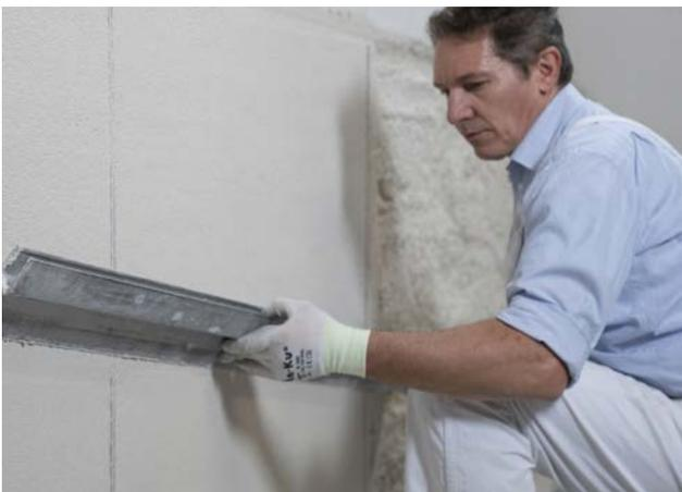
Después de la aplicación, **FASSA ONE DRY** se regulariza con una regla en H o cuchillo en pasadas horizontales y verticales hasta obtener una superficie plana.
