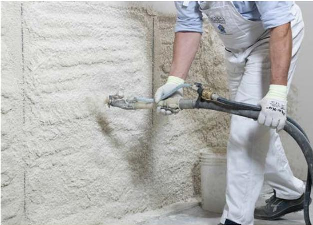
Si se trabaja a mano, verter el producto en la cantidad correspondiente de agua limpia y mezclar durante 3 o 4 minutos hasta conseguir la consistencia deseada. El mortero, una vez mezclado con agua, debe aplicarse antes de 45 minutos en condiciones termohigrométricas normales. **FASSA ONE DRY** se aplica de abajo hacia arriba.
