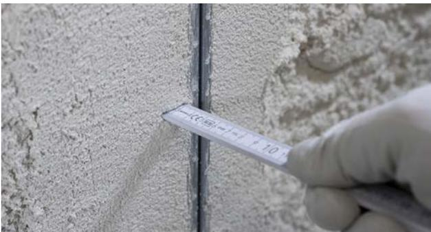
**FASSA ONE DRY** se aplica en espesores no inferiores a 20 mm (se recomienda un mínimo de 30-40 mm). Para espesores superiores a 30 mm, el revoco debe aplicarse en varias capas sucesivas, y cada capa se aplicará una vez fraguada la capa inferior. Esta última debe mantenerse rugosa, por lo que debe alisarse sin comprimir el producto.
