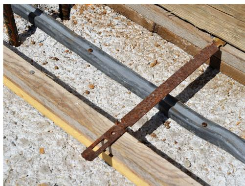
Durante la colocación de AQUAZIP JOINT evitar cualquier situación que pueda provocar el aplastamiento de la junta de bentonita o que impida su confinamiento regular por la colada de hormigón.
